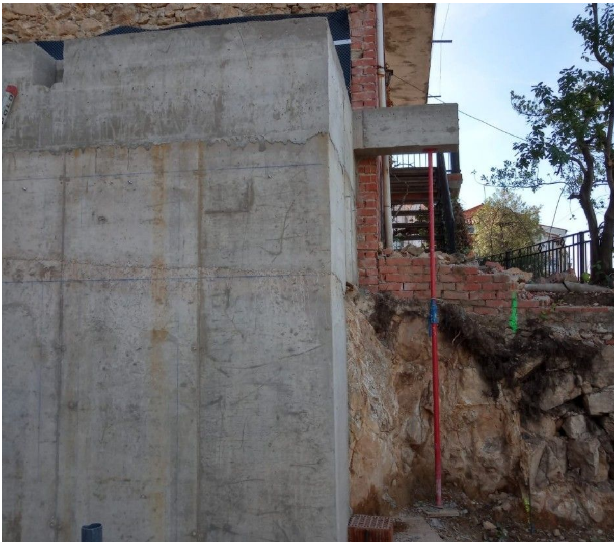
Ilustración 2: Muro de contención sobre roca madre.
