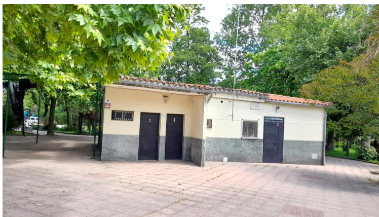
Vista general exterior, acceso a aseos.
