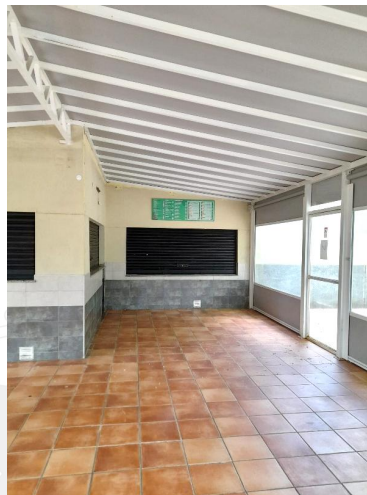
Vista interior de terraza y zona de mostrador.
