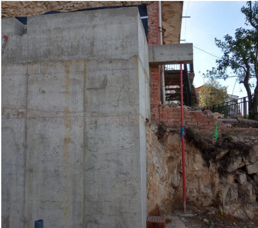
Ilustración 2: Muro de contención sobre roca madre.
