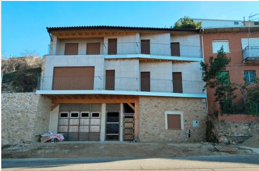
Ilustración 4: Fachada oeste afectada por la alineación
